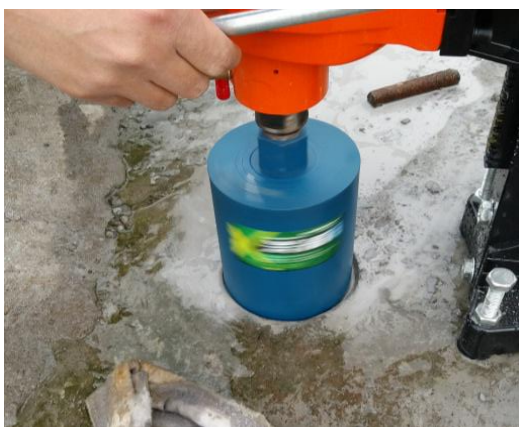
图 2.4-5 充填体现场取样
