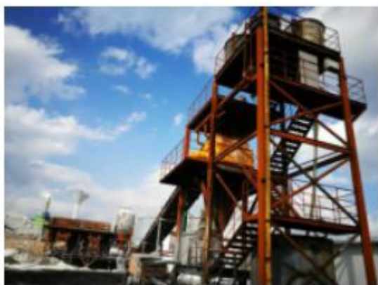
图 2.4-1 磷石膏制备充填站
