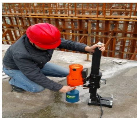
图 2.4-6 充填体现场取样
