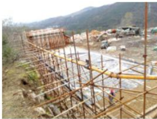
图 2.4-2 中间试验装置充填分区
